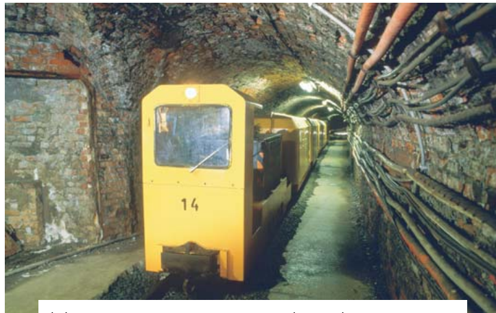
Una mina por dentro
